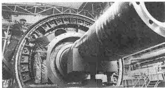
Montaje de un electromotor en la fábrica.
