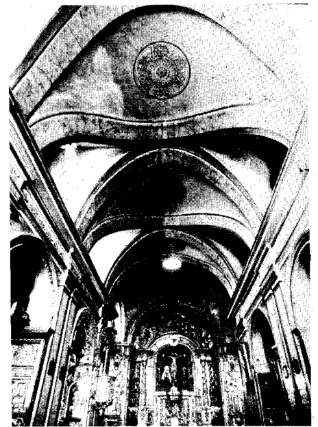
152. Ecuador, Quito, capilla de Cantuña, bóvedas de doble curvatura. Siglo XVIII
