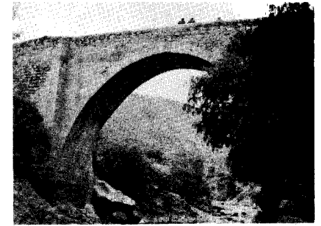
319. Perú, Abancay (Apurímac), puente de Pachachaca. Siglo XVIII
