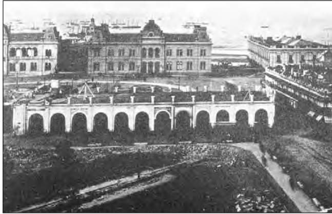
Casa de Gobierno de Julio A. Roca en espejo con el Palacio de Correos. Recova en demolición.
