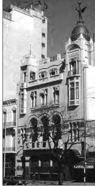
Espléndido edificio del Club Español de Buenos Aires, 1911.
