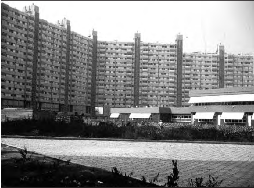
Conjunto habitacional Lugano I-II, Barrio Almirante Brown, Buenos Aires: tecnología de refabricación mixta de patente francesa, 1972.
