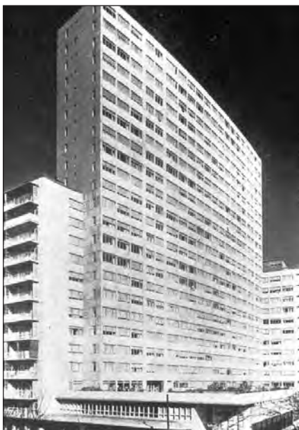
Conjunto habitacional colectivo y fábrica con comercios en su base; promovida por la progresista Cooperativa "El Hogar Obrero", Av. La Plata y Rivadavia, Buenos Aires.
