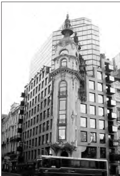
Rescate de iconos memorables: obra nueva con preservación de remate Art Nouveau preexistente de esquina en el barrio de Tribunales, Buenos Aires.
