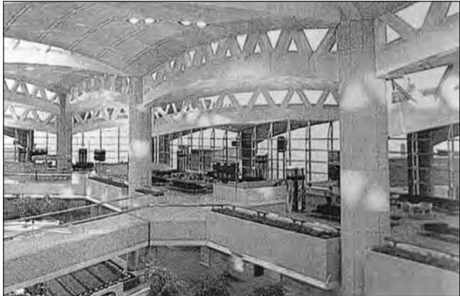
Fotos 1 y 2. Cubiertas aireadas del aeropuerto Rey Khaled de RIAD, a semejanza de los sistemas tradicionales de aireación de la misma región.
