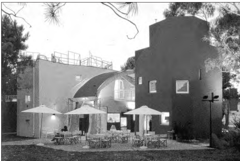
Centro de exposiciones en Cariló, Provincia de Buenos Aires, Argentina; Clorindo Testa, 2000.
