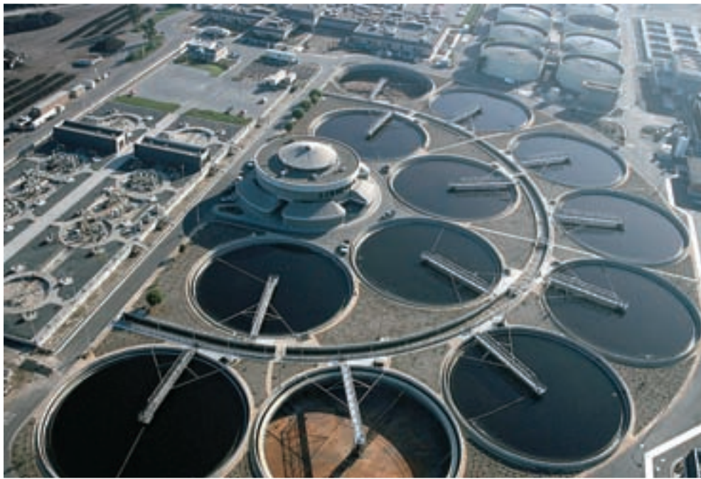
► Planta de tratamiento de agua.
